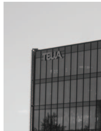
Telia Glasfacade mod Kløvermarken 2008 Foto: Ulrik Stylsvig Madsen
